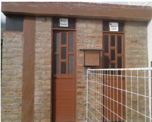
Fotografía 6. Rotulación de instalaciones
