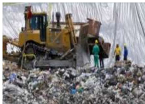
Figura 4. Relleno semi-mecanizado
