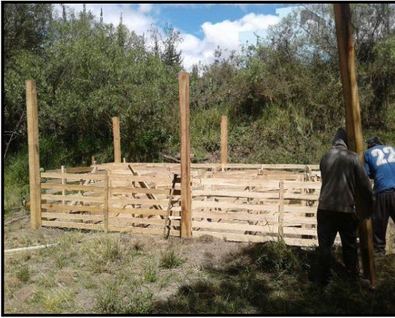
Foto 2: Construcción del galpón para los ovinos
