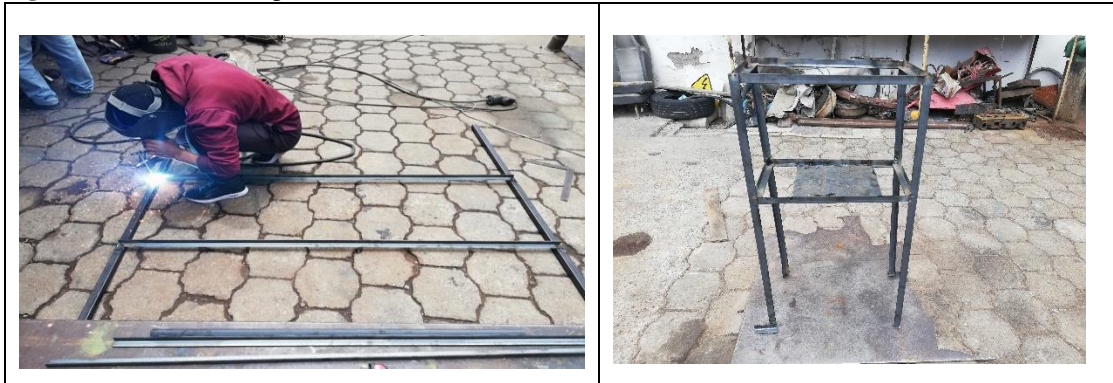
Figura 22. Soldadura de piezas metálicas
