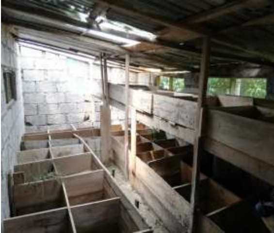
Figura N°26: Armado final de cajones individuales.
