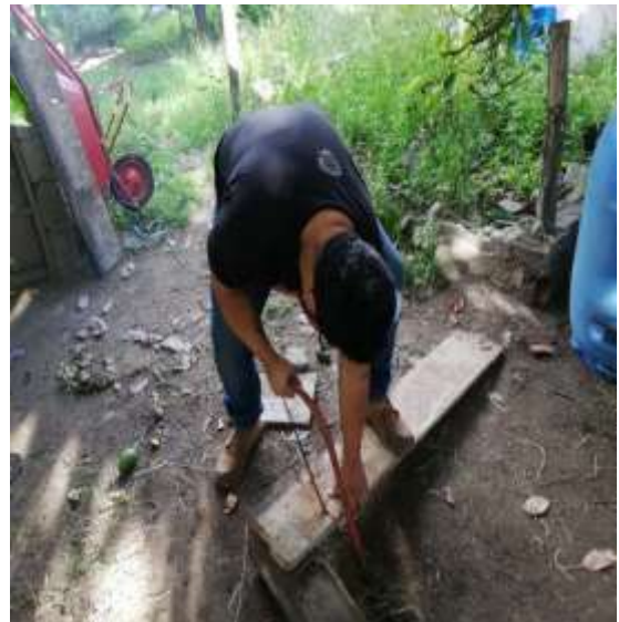
Figura N°25: Corte de tablas para su posterior armado.
