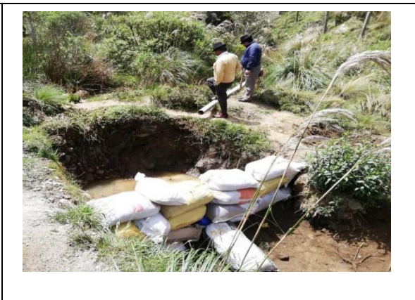
Ilustración 17: Construcción del muro de costales de tierra
