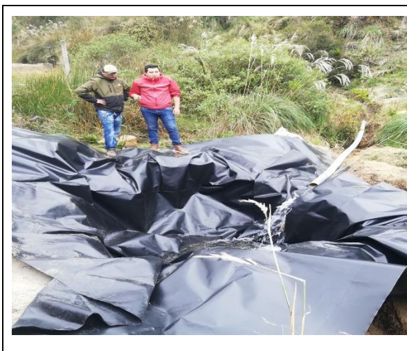
Ilustración 18: Instalación de la geomembrana
