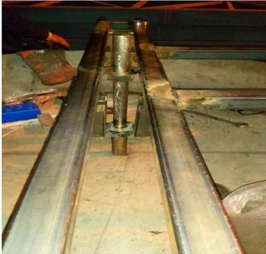
**Figura A13.** Instalación del eje de las aspas
