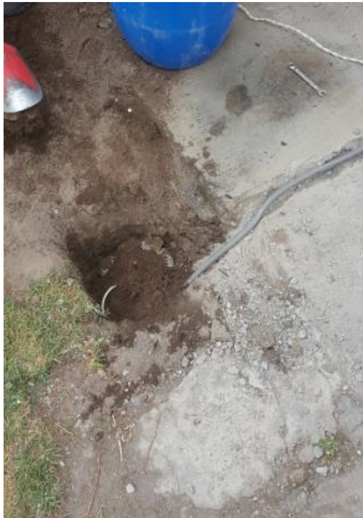
Fig. 22. Sistema de puesta a tierra
