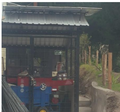
Fig. 16. Ubicación de los paneles solares.
