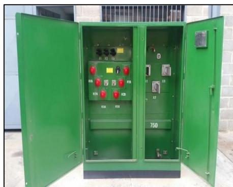
**Figura 1.1** Transformadores tipo Pedestal [12].
