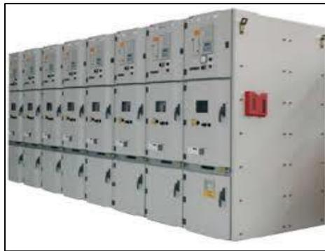
**Figura 1.4** Celdas de medio voltaje aisladas en SF6 [12].
