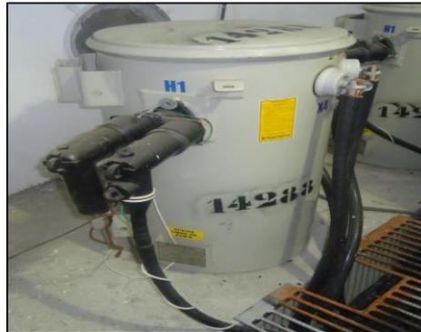
**Figura 1.2** Transformador con frente muerto [12].
