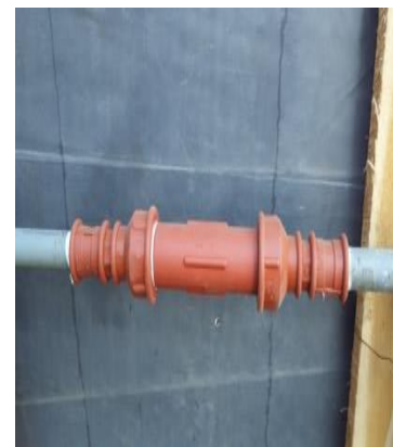
Figura 4.5 Filtro sulfhídrico.
