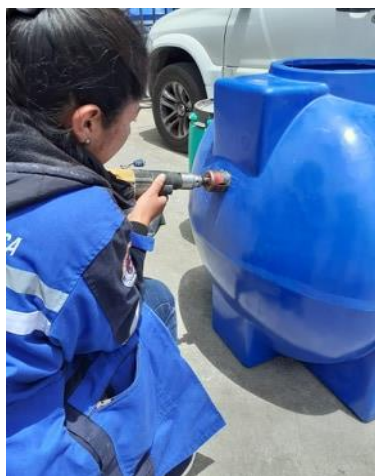
Figura 5.11 Instalación de acoples y tubería del biodigestor. Fuente: [Autor].
