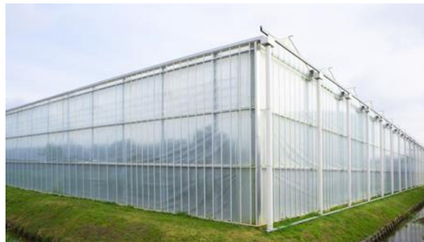
Figura 9. Cubierta de invernadero para el biodigestor.
