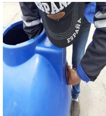
Figura 5.11 Instalación de acoples y tubería del biodigestor. Fuente: [Autor].
