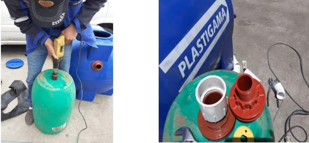
Figura 5.12 Instalación de los tanques de pre mezcla y descarga. Fuente: [Autor].
