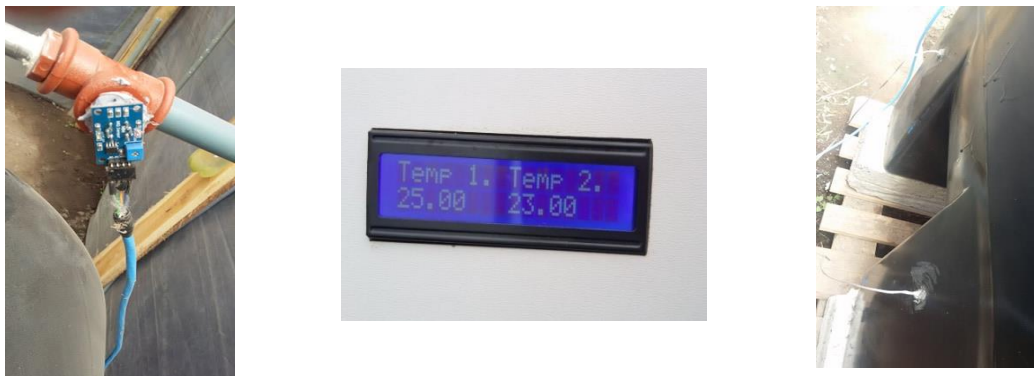
Figura 5.15 Instalación de elementos electrónicos. Fuente: [Autor].
