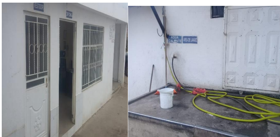
Ilustración 5 Oficina de Administración y Área de recepción de la leche
