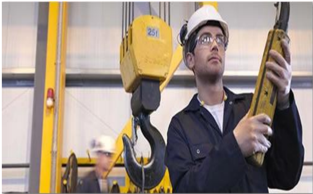
Gráfico N° 18: Puente Grúa 5 toneladas
