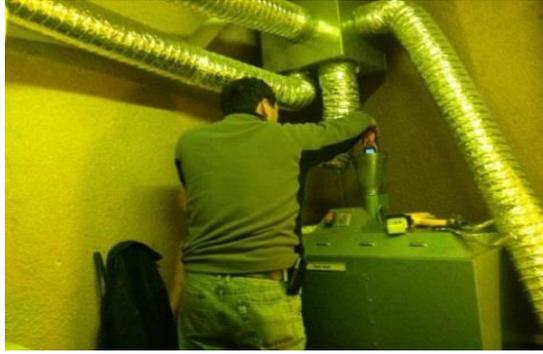
Figura 3.7. Medición de velocidad de extracción de gases
