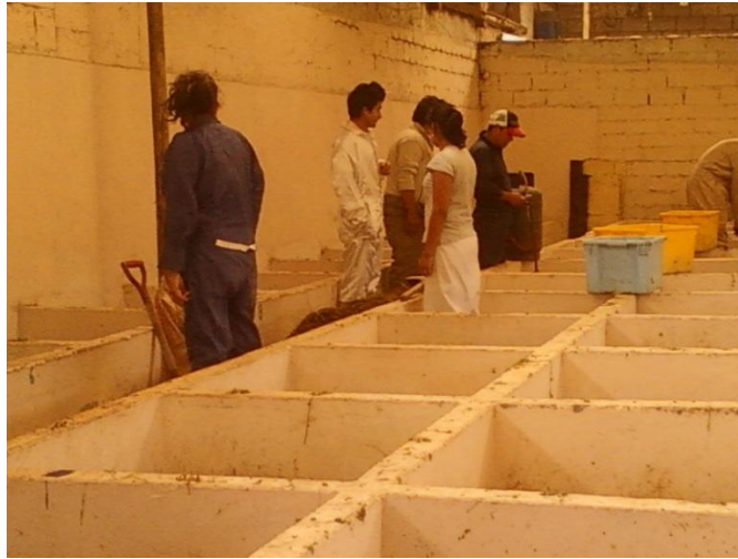
FOTO 7: DESINFECCIÓN DE POZAS
