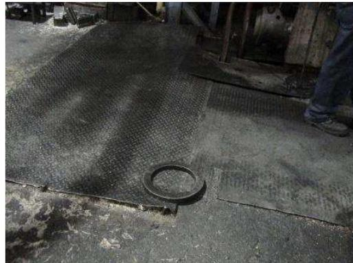
Figura 22. Pisos en mal estado de extrusión
