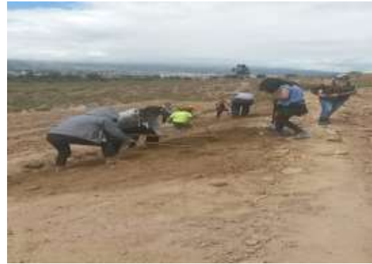
Fotografía 4: Elaboración de los taludes
