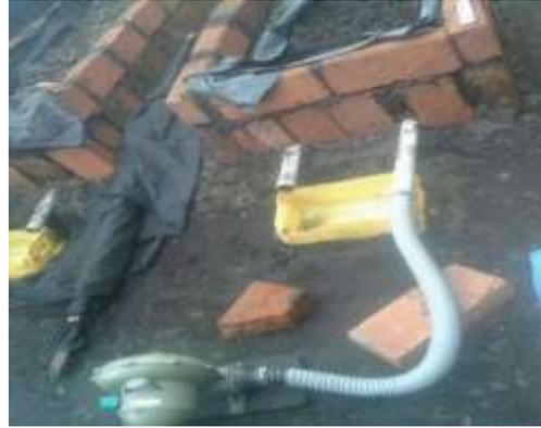
Instalación de aireación forzada
