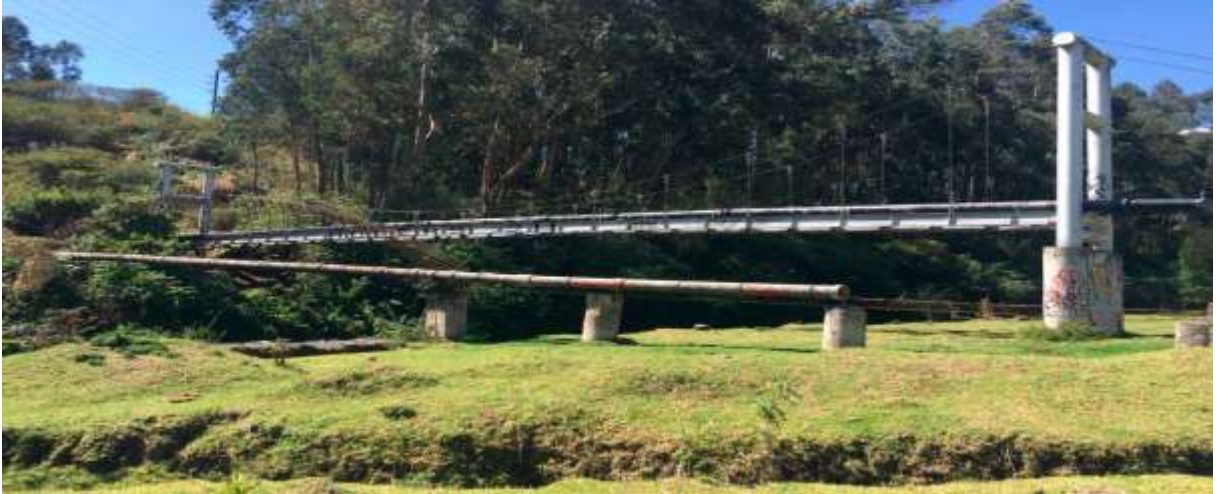
Figura 6 Tubería de procedencia desconocida
