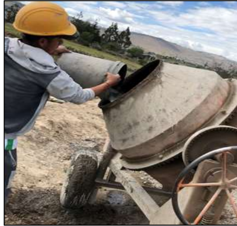
Figura 2: Concretera con agua. Fuente: Constructora Gutiérrez.
