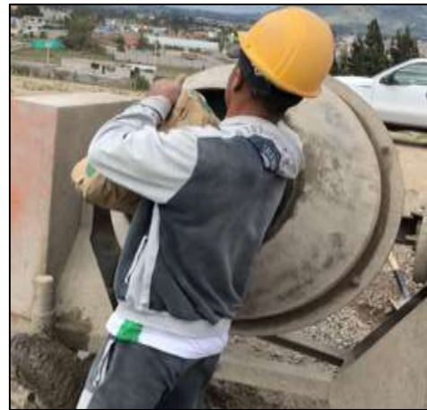
Figura 4: Concretera con cemento. Fuente: Constructora Gutiérrez.
