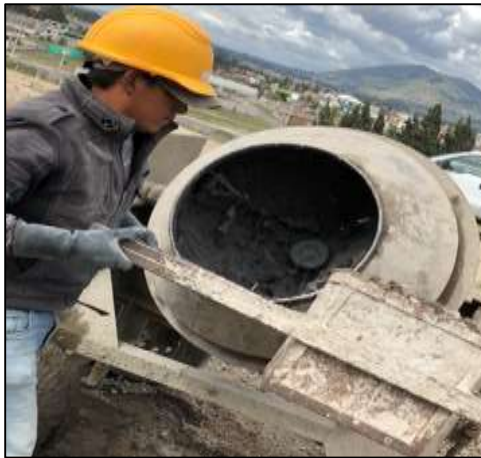
Figura 3: Concretera con ripio. Fuente: Constructora Gutiérrez.
