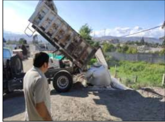
Figura 2: Descarga de lodo. Fuente: Adoquines Balarezo.
