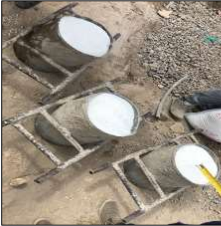
Figura 1: Parihuelas con lodo. Fuente: Constructora Gutiérrez.
