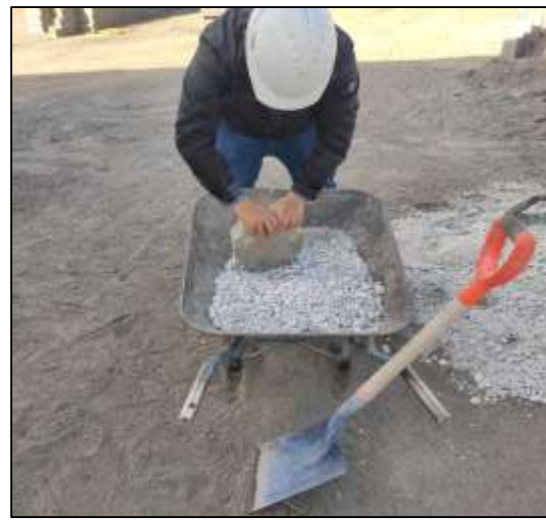
Figura 4: Trituración de lodo. Fuente: Adoquines Balarezo.
