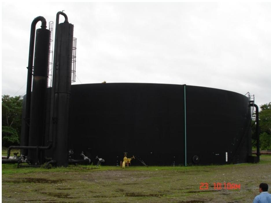
**Figura 14: Tanque de lavado estación Lago Norte**
