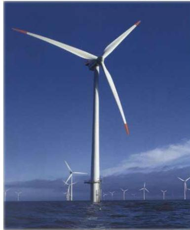
**Gráfico 1.3. Aerogenerador de eje horizontal.**
