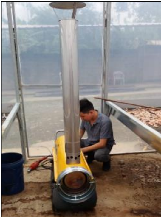
Fotografía 22: Instalación de generador de aire. Fuente: Cuasquer C., Villegas J.
