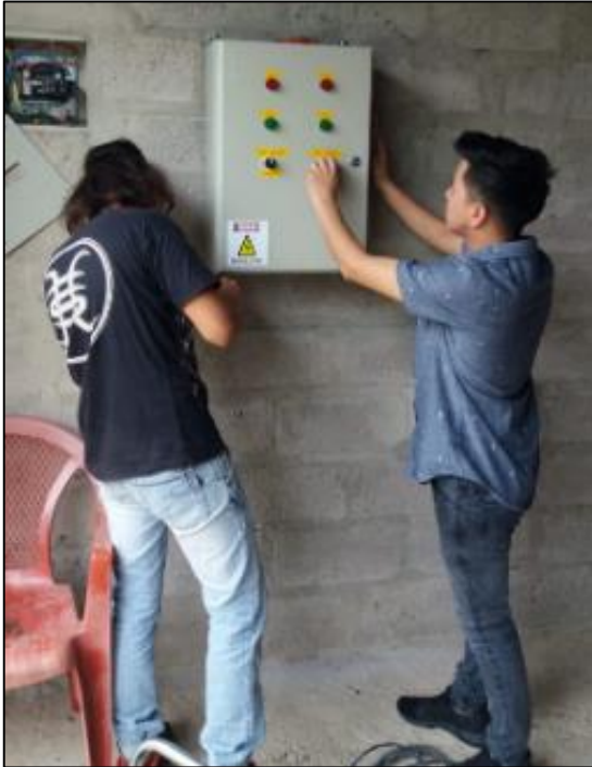
Fotografía 20: Instalación de caja de control. Fuente: Cuasquer C., Villegas J.
