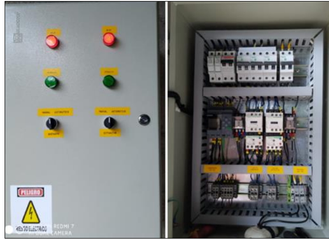
Fotografía 6: Montaje de caja de control. Fuente: Cuasquer C., Villegas J.
