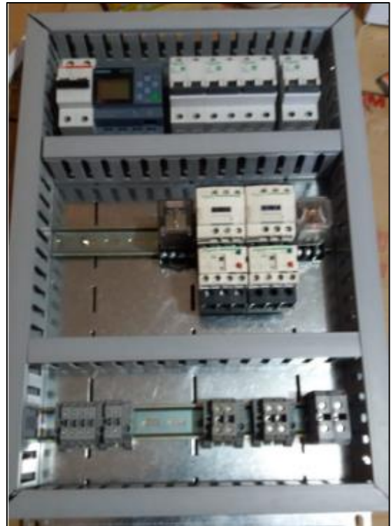
Fotografía 15: Montaje de dispositivos eléctricos y electrónicos. Fuente: Cuasquer C., Villegas J.
