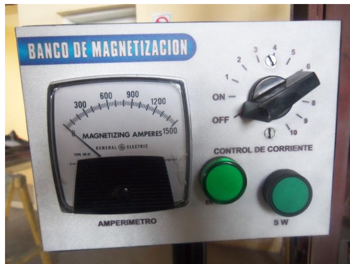
Montaje de la señalética del panel de control
