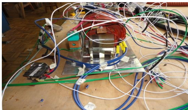
Instalación del cableado del transformador de potencia
