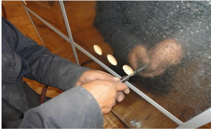
Apertura de orificios para los terminales de salida del equipo eléctrico
