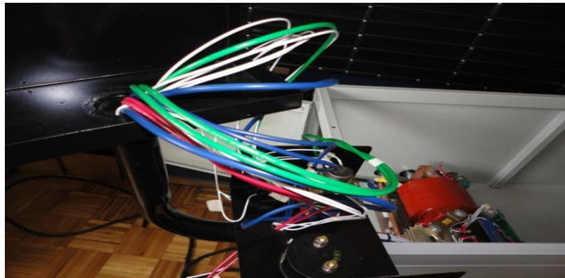
Ruteado del cableado hacia el panel de control
