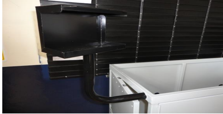
Montaje del soporte del panel de control a la estructura
