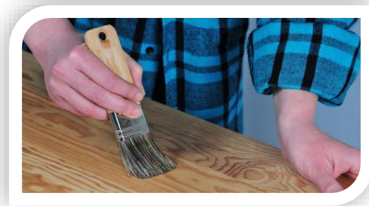
Figura 26 Sellado de madera
