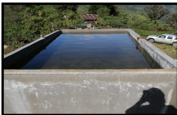
Imagen: Reservorios de concreto
