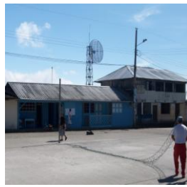
Central de telecomunicaciones Las Pampas
