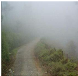
Carretera lastrada, Vía Toachi - Las Pampas
