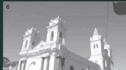
Vista de la iglesia central de Machachi
