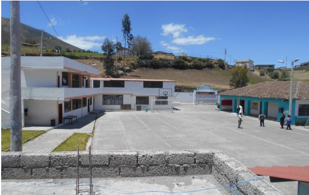
Fotografía 1: instalaciones de la escuela “Canadá”
