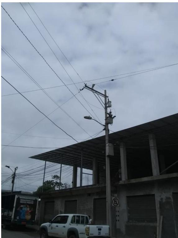
**Derivación de la troncal trifásica de 3/0 a la Isla con calibre de conductor 2**
