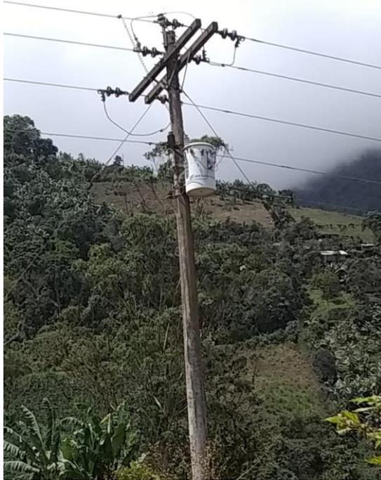
**Derivación de la troncal trifásica de 1/0 a Suncamal con calibre de conductor**
