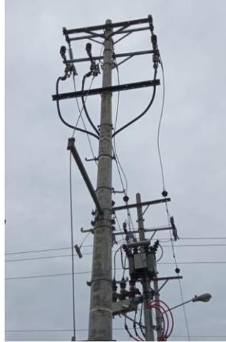
Figura 32. Pararrayos de medio voltaje en la red de interconexión Gasgreen - EEQ
