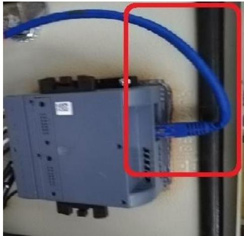
Figura 2.6: Conexión física RJ-45-MODBUS
