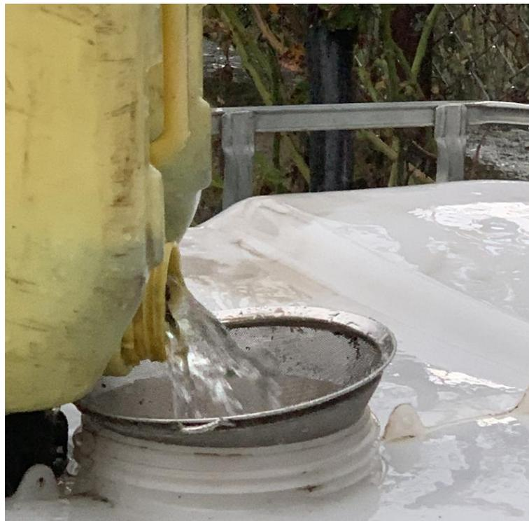
Paso del agua de lluvia por el filtro y almacenamiento en un IBC
