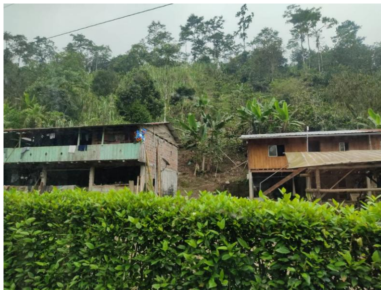
Construcción de viviendas
