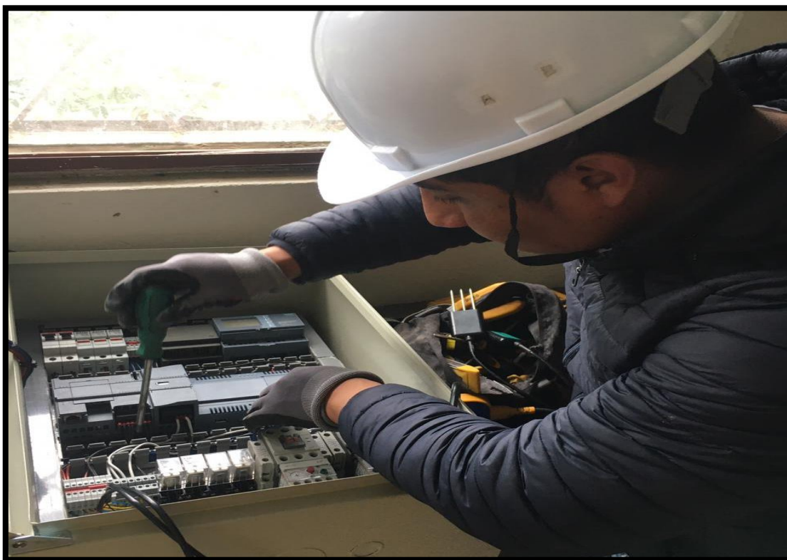
Figura IX.1: Ajuste de borneras
