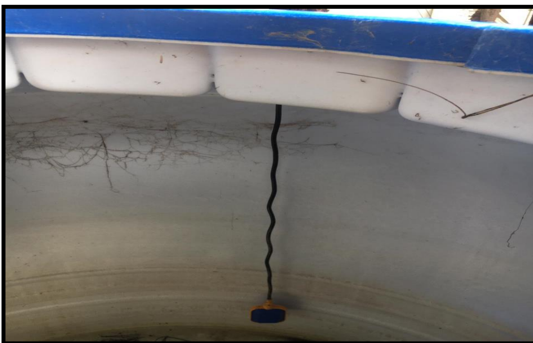
Figura XVI.1: Colocación del flotador de nivel
