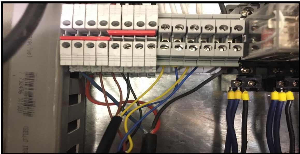
Figura XIII.1: Conexión de electroválvulas
