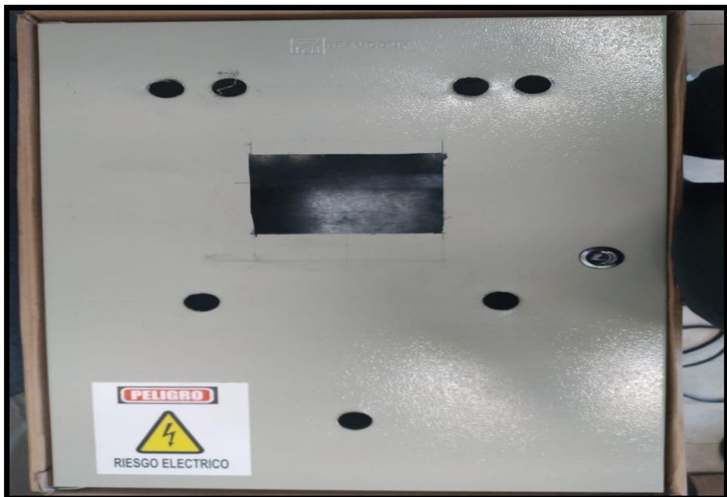
Figura VI.1: Perforacion de tablero
