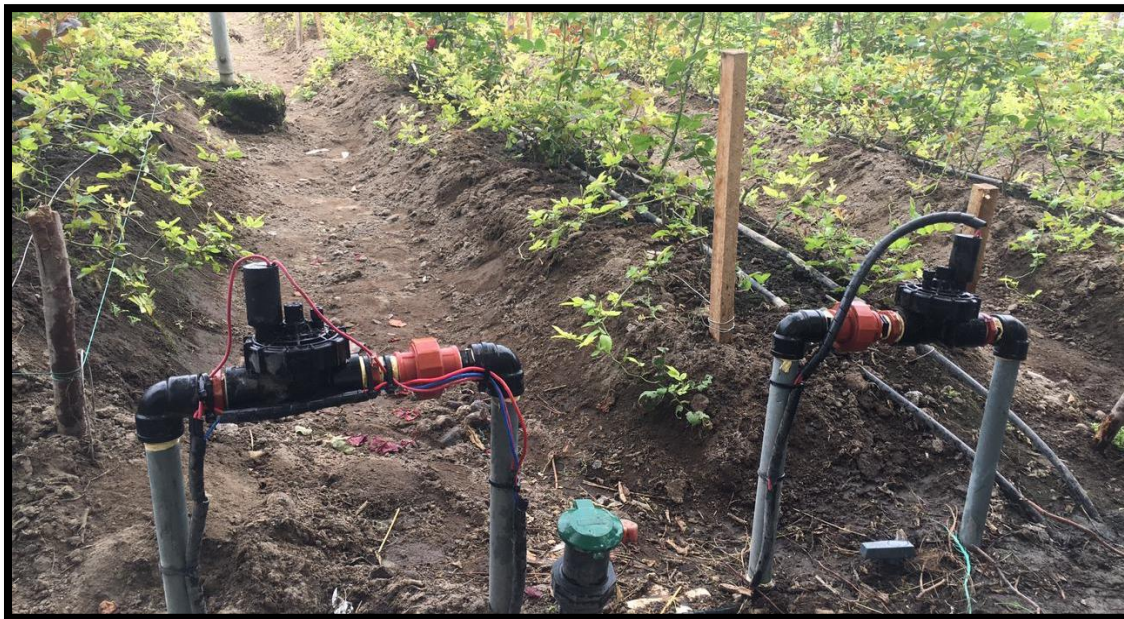
Figura XVII.1: Prueba de activación de electroválvulas
