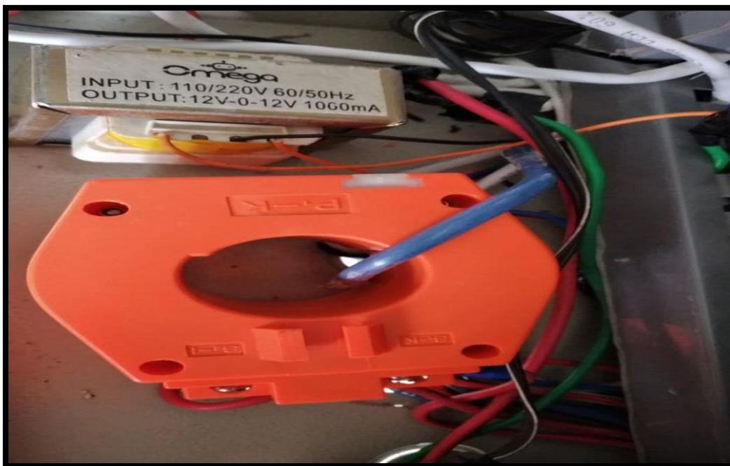
Figura XXIII.1: Conexión del TC
