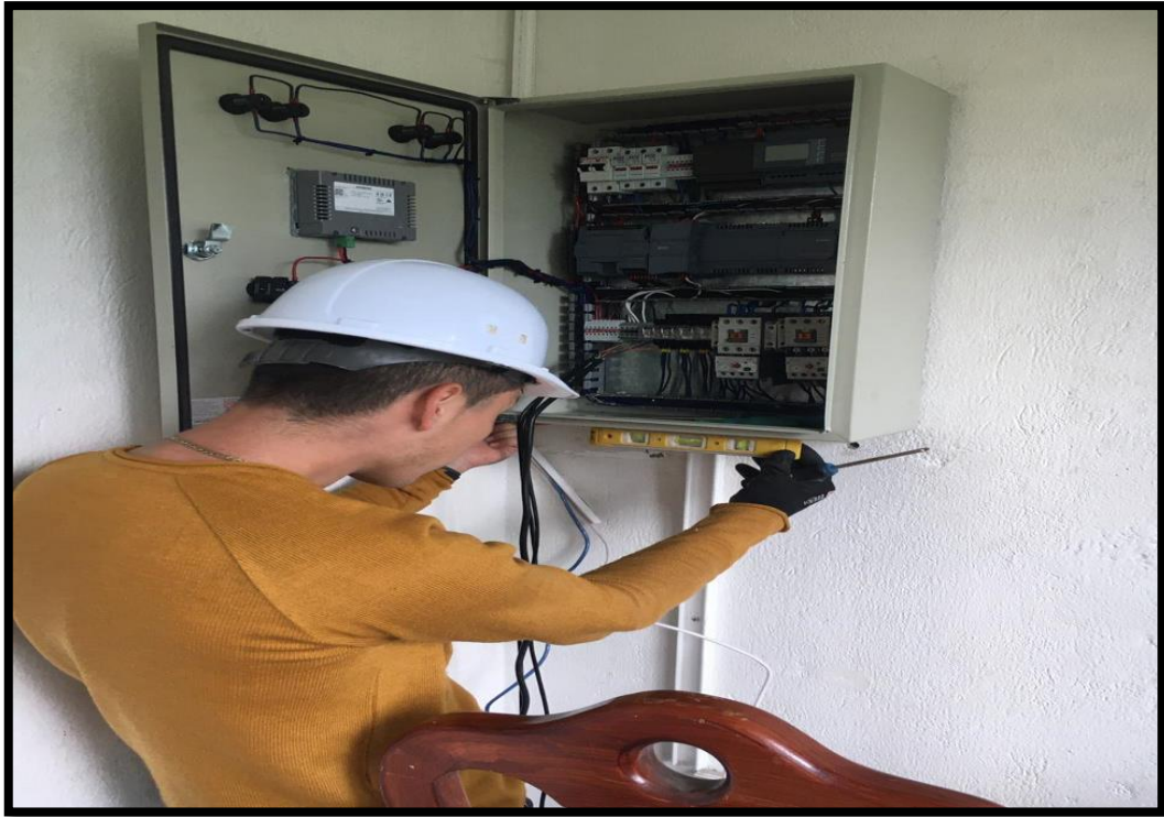
Figura XI. 1: Colocacion de tablero de control
