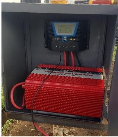
4) Visualizar que el voltaje del REGULADOR, que debe ser de 12,5 V, para poder cargar las baterías y arrancar el INVERSOR.
