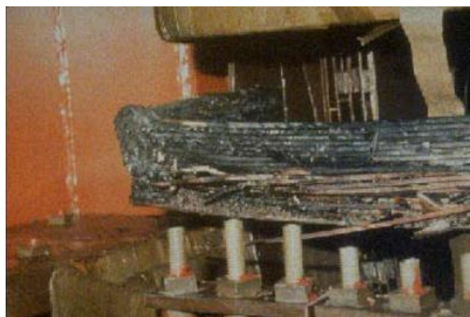
Figura 8.13. Transformador dañado por Sobrecalentamiento en la tormenta solar de marzo de 1989 [21].
