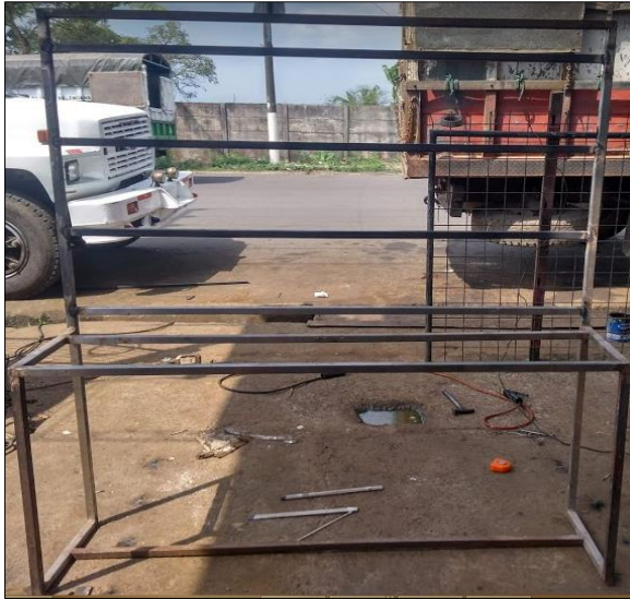
Proceso de elaboración de la estructura del módulo
