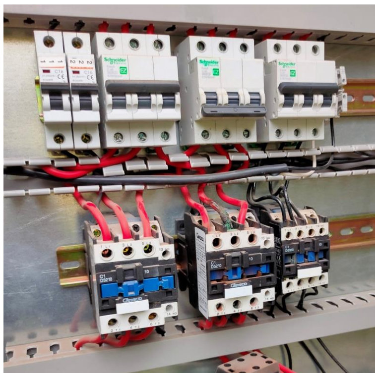
Figura C.3. Contactores cortocircuitados
