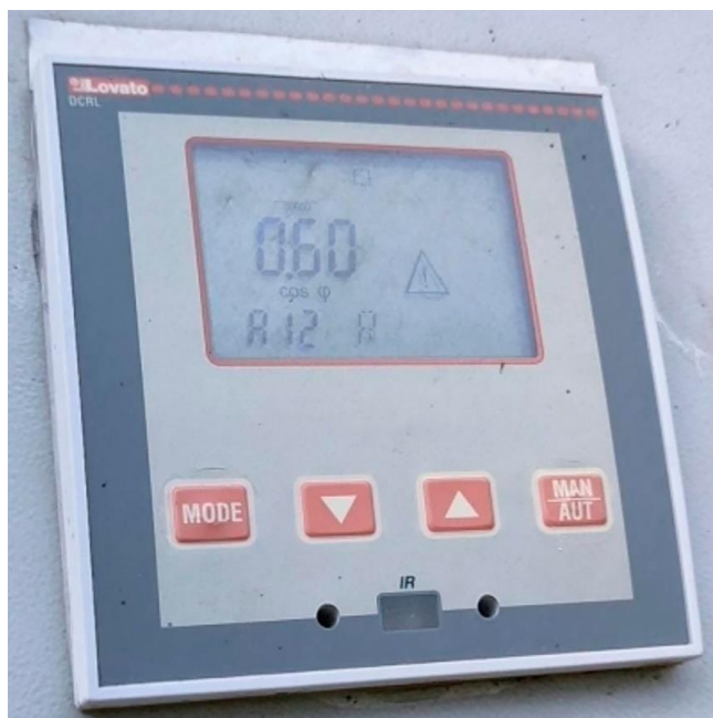
Figura C.2. Controlador de factor de potencia encontrado
