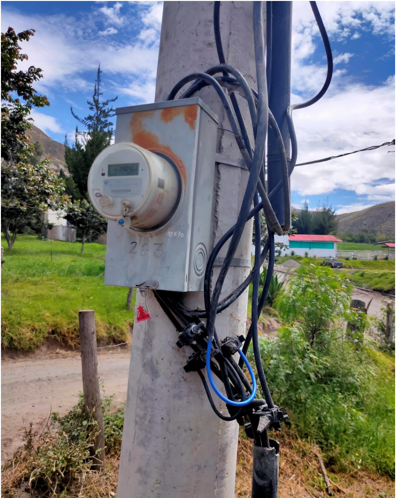
Figura D.5. Banco de capacitores aguas abajo del medidor.
