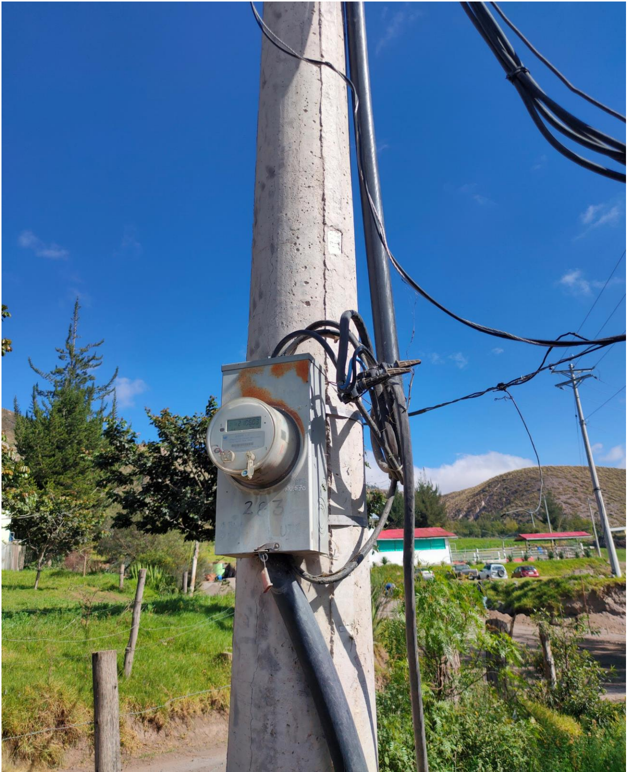
Figura D.2. Banco de capacitores aguas arriba del medidor
