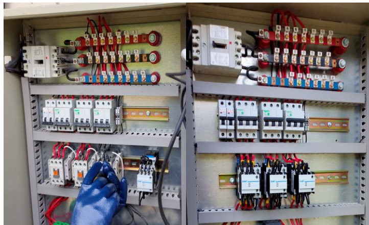
Figura 5.13. Contactores que fueron reemplazados en el gabinete de capacitores.
