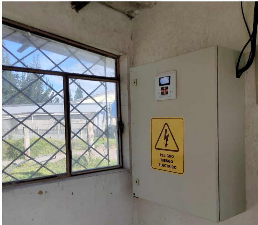
Figura D.7. Reubicación de gabinete (Cuarto de Bombas).
