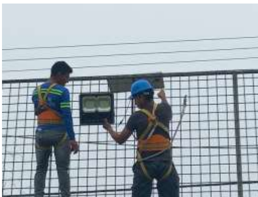
Foto 5: Proceso de instalación
