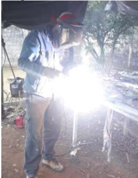
Figura 16: Soldadura con electrodo 6013
