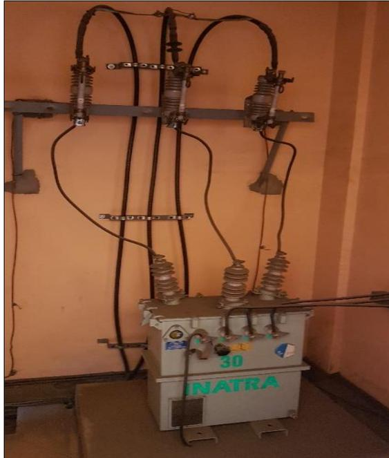
Figura 8. Transformador de distribución de la Universidad Técnica de Cotopaxi - Campus Pujlí
