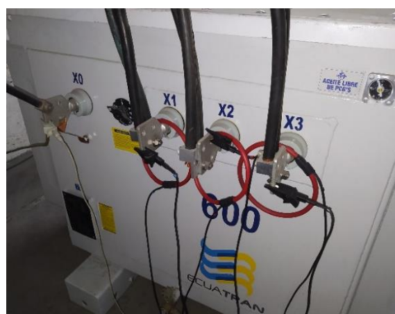
(b) Conexión de las pinzas a las fases de alimentación.
