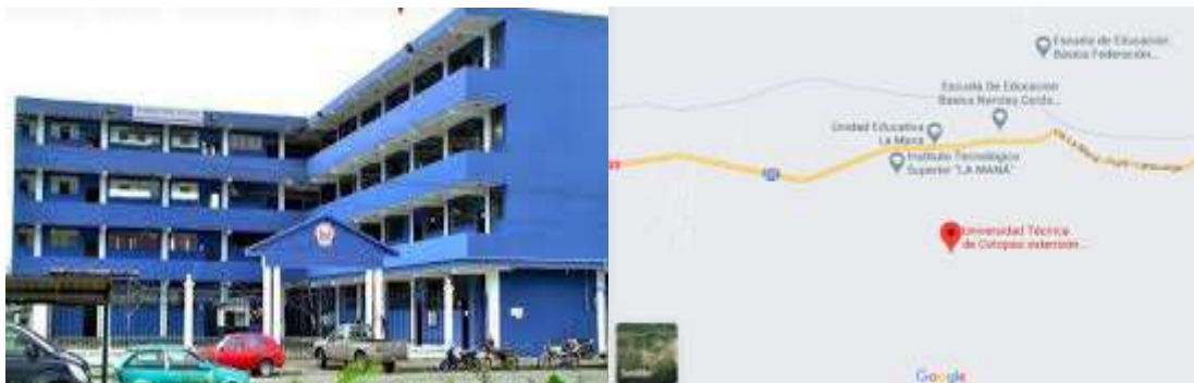
Figura 33. Localización e infraestructura UTC La Maná
