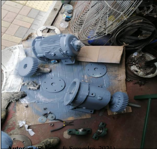
Anexo 16: Pintado al moto-reductor y a los engranajes
