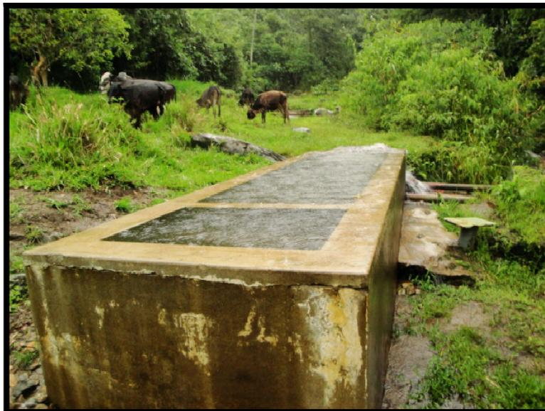
Captación de agua potable en mal estado con presencia de ganadería junto al río.
