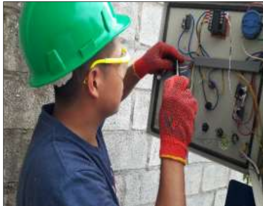
Figura 57 Unión de cableado
