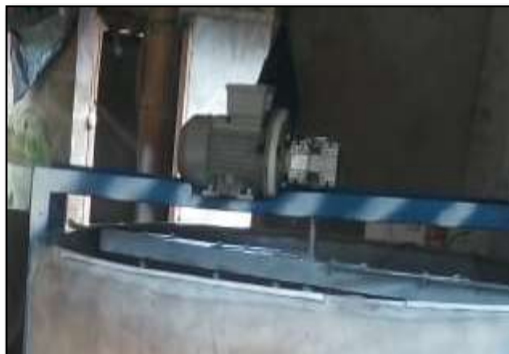
Figura 43 Colocación del motor reductor
