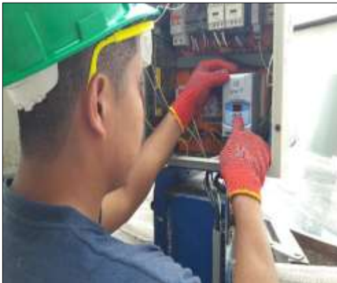
Figura 61 Programación del variador de frecuencia, según las variables de salida.
