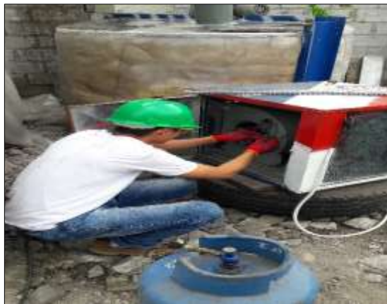
Figura 58 Instalación del motor y capacitor del ventilador
