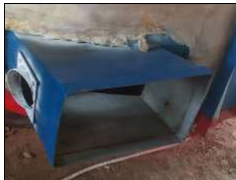
Figura 45 Estructura del ducto de ventilación soldada al contenedor.
