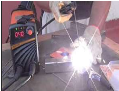
Figura 42 Soldadura para el soporte de secador.
