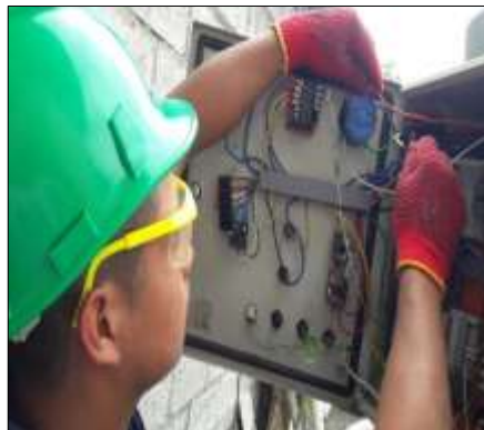
Figura 56 Instalación de los selectores y otros elementos
