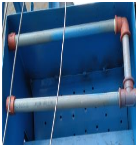
ANEXO X. Montaje de la tolva de ingreso
