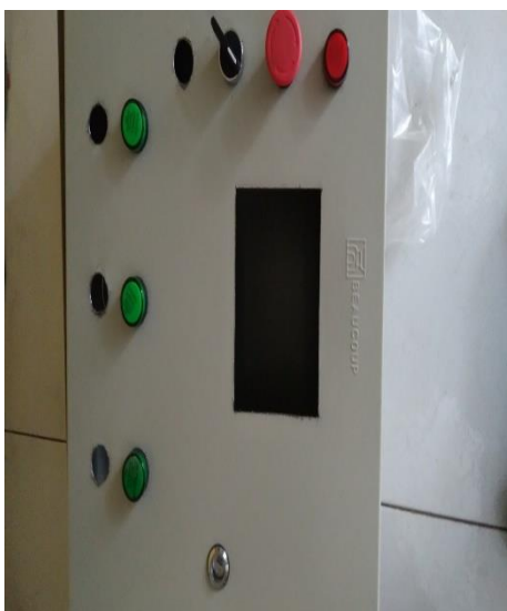
Anexo XII. Colocación de elementos
