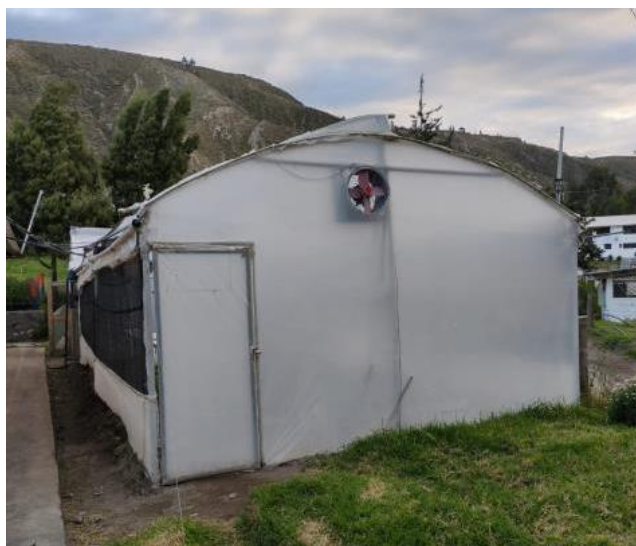
Figura 5.1 Vista Frontal del Invernadero.
