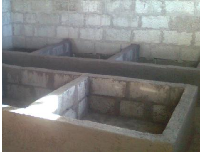
Preparación y adecuación del galpón.
