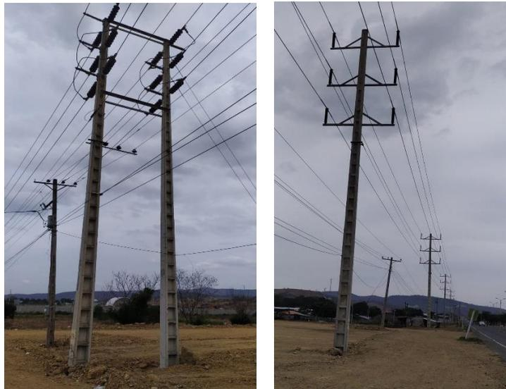
Figura 2 Postes rectangulares de 69 kV
