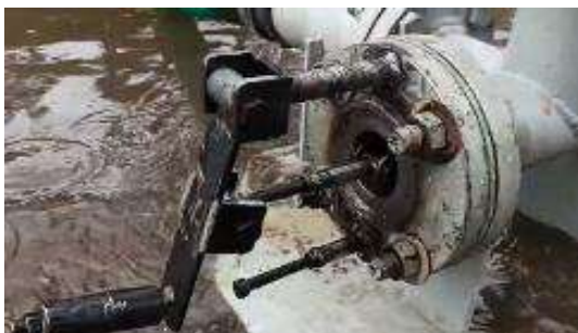
Figura 5.38. Accionamiento de la válvula check.
