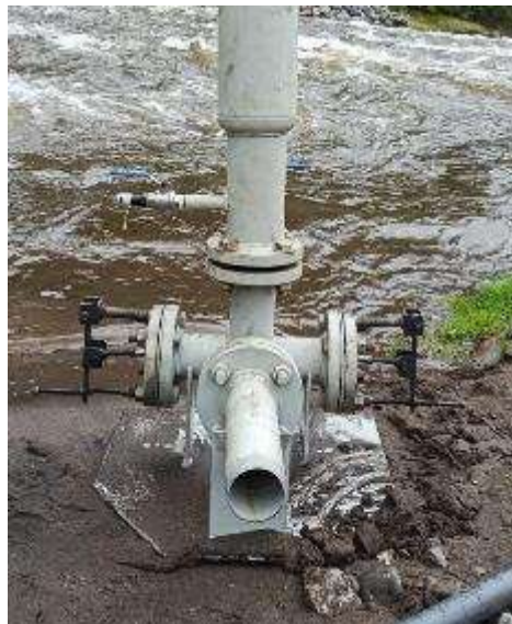
Figura 5.37. Instalación de ariete hidráulico modificado.
